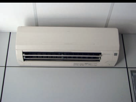
ALL'INTERNO. Installazione dell'unità interna sulla parete divisoria dei locali.
