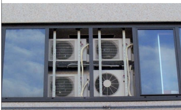
L'EDIFICIO. L'esterno della struttura presso la quale è avvenuta l'installazione degli scarichi condensa. Le motocondensanti sono nascoste e integrate nella struttura grazie alla nicchia e alla griglia metallica.
