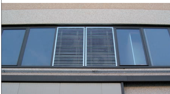
L'EDIFICIO. L'esterno della struttura presso la quale è avvenuta l'installazione degli scarichi condensa. Le motocondensanti sono nascoste e integrate nella struttura grazie alla nicchia e alla griglia metallica.
