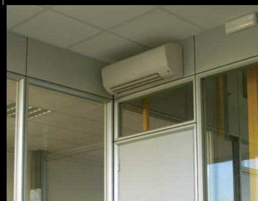
VERSATILITÀ. L'installazione di un'unità interna su parete esterna e sopra alla porta.
